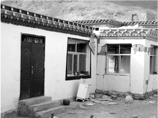
图 9 农牧民安居房(2009 年建成)(左)和自建房(右)破坏情况对比
